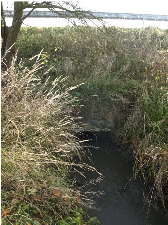
Vyústění odpadního potrubí DN600 od spodní výpusti
