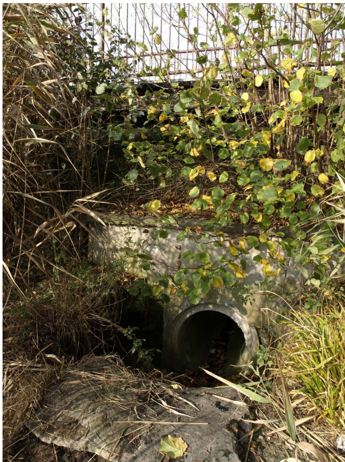
Bezpečnostní přeliv- pohled ze zátopy rybníka
